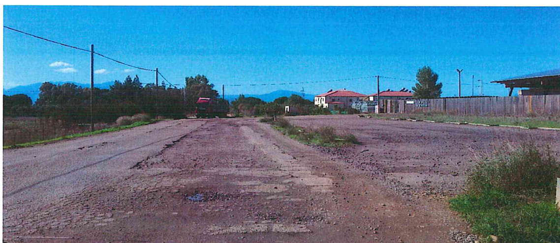
Viabilità secondaria (pressi svincolo ss 131 km 14)
